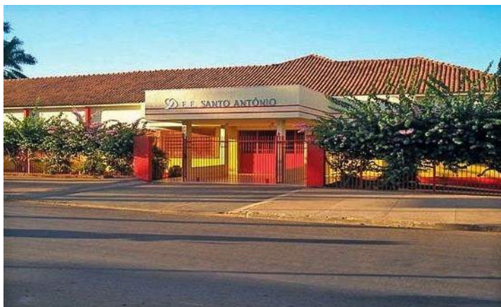
Figura 1: Fachada da Escola Estadual Santo Antônio
