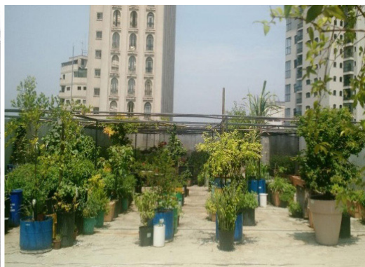
Foto 15: Telhado do edifício Ruy Barbosa depois da implantação da horta orgânica, quando passou a ser chamado de Telhado Verde (Acervo do Colégio)
