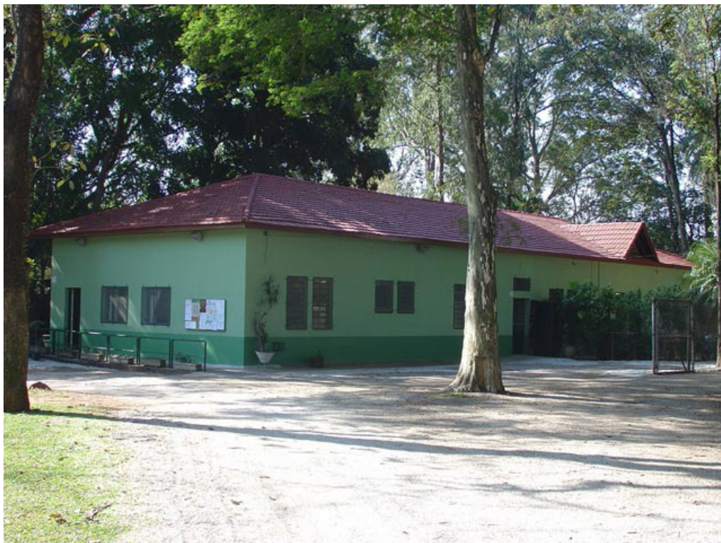
Instalações do Cecco, no Parque do Ibirapuera, São Paulo
