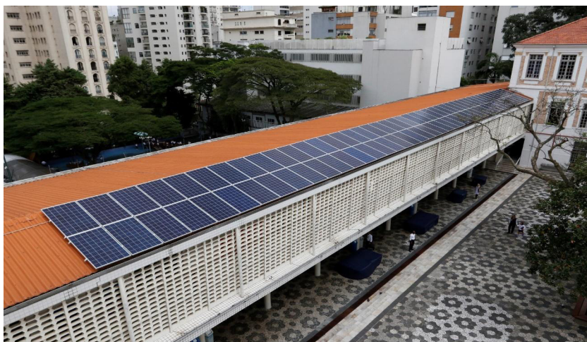
Foto 12: Painéis de Energia Solar (Acervo do Colégio)
