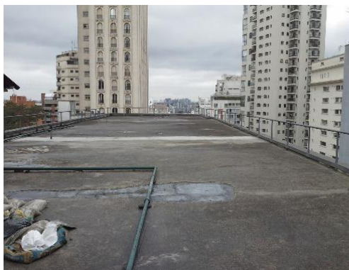
Fotos 14: Telhado do edifício Ruy Barbosa, antes da adaptação para a horta orgânica (Acervo do Colégio)
